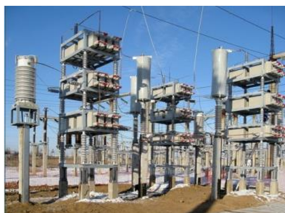
Рис. 2.10. Батарея статических конденсаторов: а – макет; б – внешний вид
