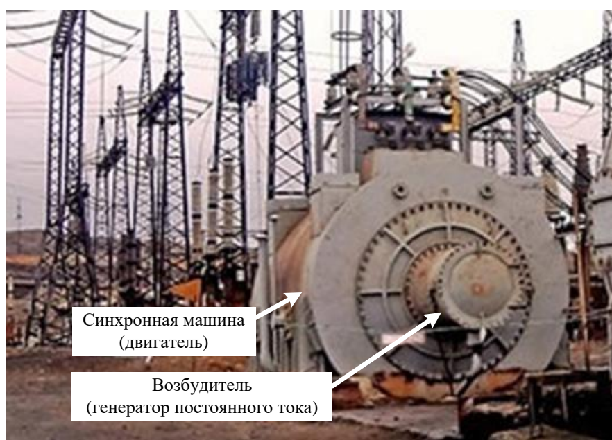
Рис. 2.9. Синхронный компенсатор на подстанции
