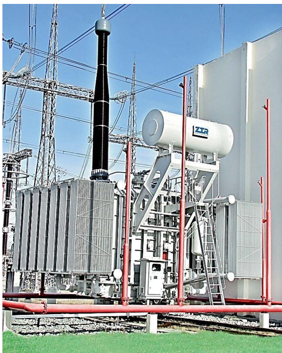
Рис. 2.13. Шунтирующий реактор 500 кВ
